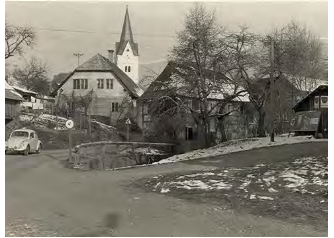
Hassler Mühle, Tankstelle
