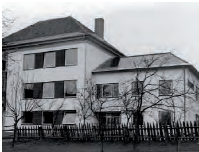
Schule nach dem Umbau 1965/66
