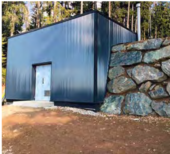
Ersatzwasserversorgung – Hochbehälter Pontnig
